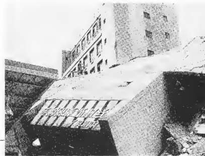
倒壊した兵庫県薬剤師会館
